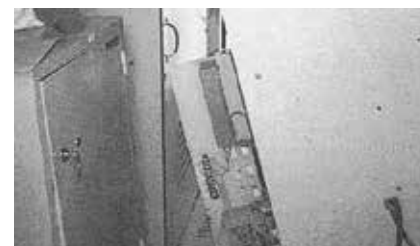
制御盤の転倒例
