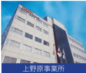
上野原事業所では、昇降機の信頼性試験の実施と評価を行っています。
