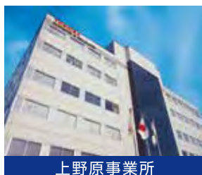
上野原事業所 上野原事業所では、制御盤の開発・組立を行っています。
