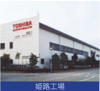
姫路工場 姫路工場では、エスカレーターの開発や設計を行っています。
