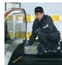
エスカレーター点検
