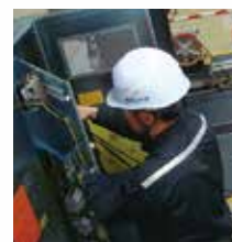
絶縁抵抗測定・ヒューズ容量確認
