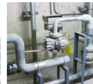
中圧ガス管化
