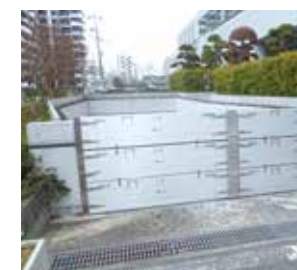
地下スロープ止水板
