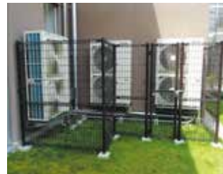
安全面に配慮しフェンスが設置された室外機
