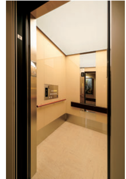
かご室 リニューアル後 (背面：ウエストパッド設置)
