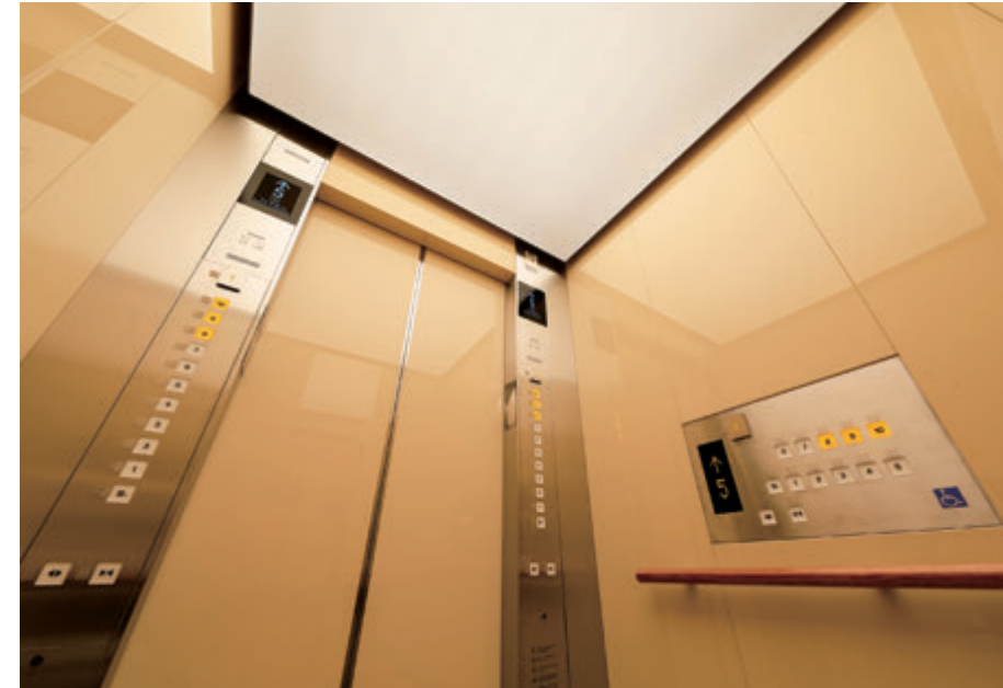
乗用15人乗エレベーター・かご室天井 リニューアル後
