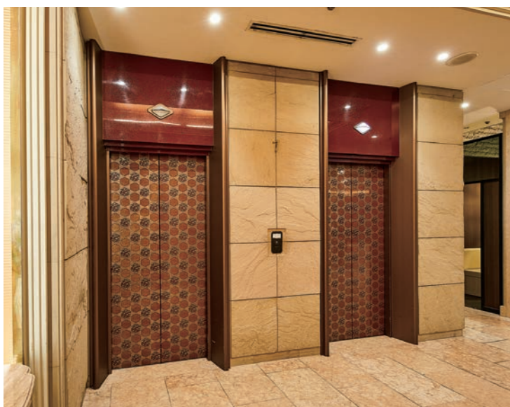
乗用15人乗りエレベーター・1階ホール(のりばボタンリニューアル後)
