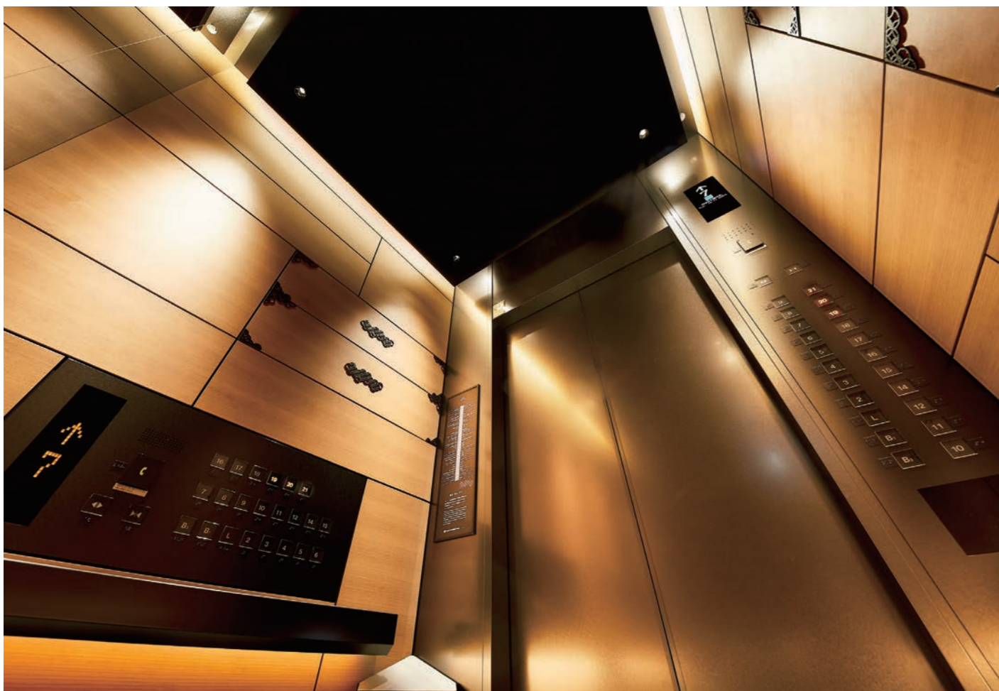
乗用15人乗りエレベーター・かご室天井(リニューアル後)
