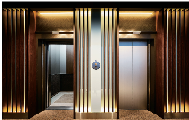
乗用13人乗りエレベーター・1階ホール(リニューアル前)
