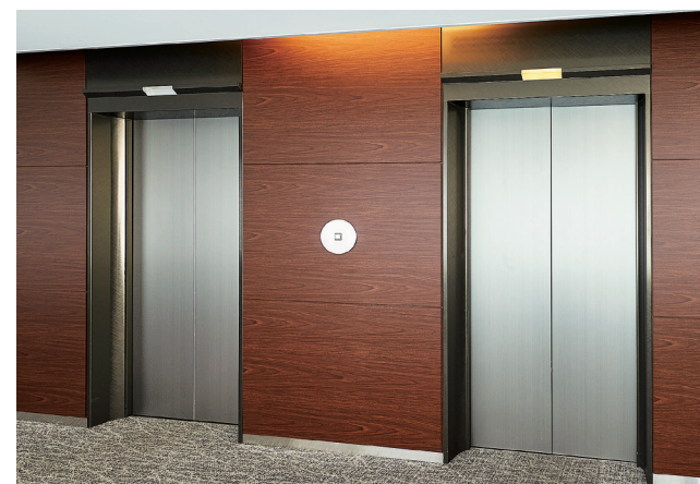
乗用13人乗りエレベーター・7階ホール(リニューアル前)
