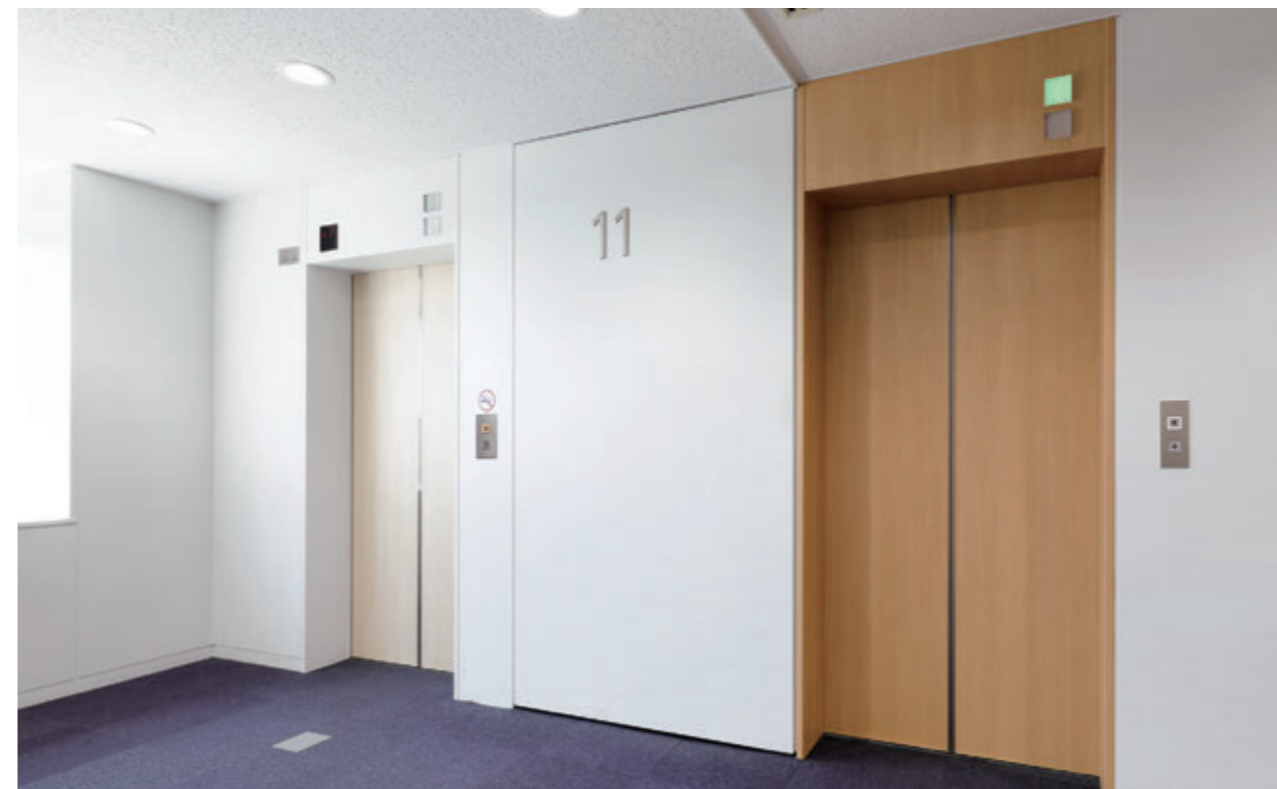
乗用(非常用)17人乗りエレベーター(左:リニューアル前)/乗用13人乗りエレベーター(右:リニューアル後)・11階エレベーターホール
