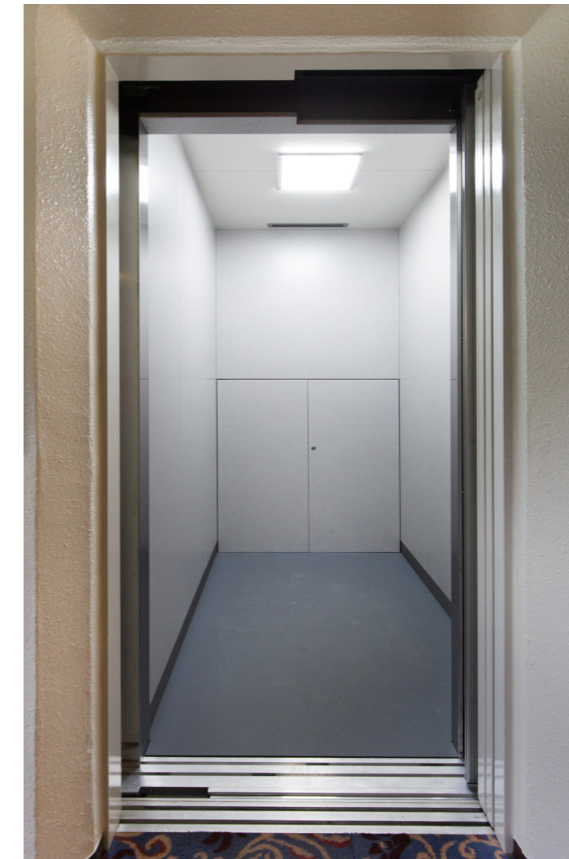
乗り場の三方枠、敷居乗り場ドアを残し、巻上機、制御盤、かご室などを最新機種に交換
