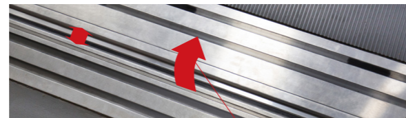
エレベーターリニューアル後
