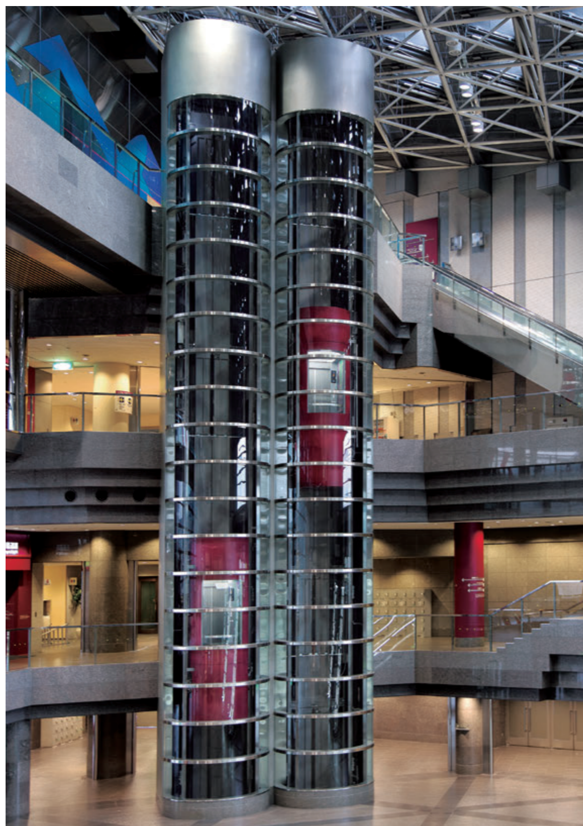
展望用15人乗りエレベーター・昇降路/かご室
