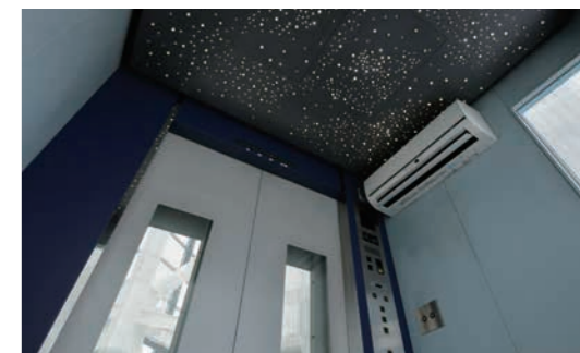
展望用エレベーター・かご室天井
