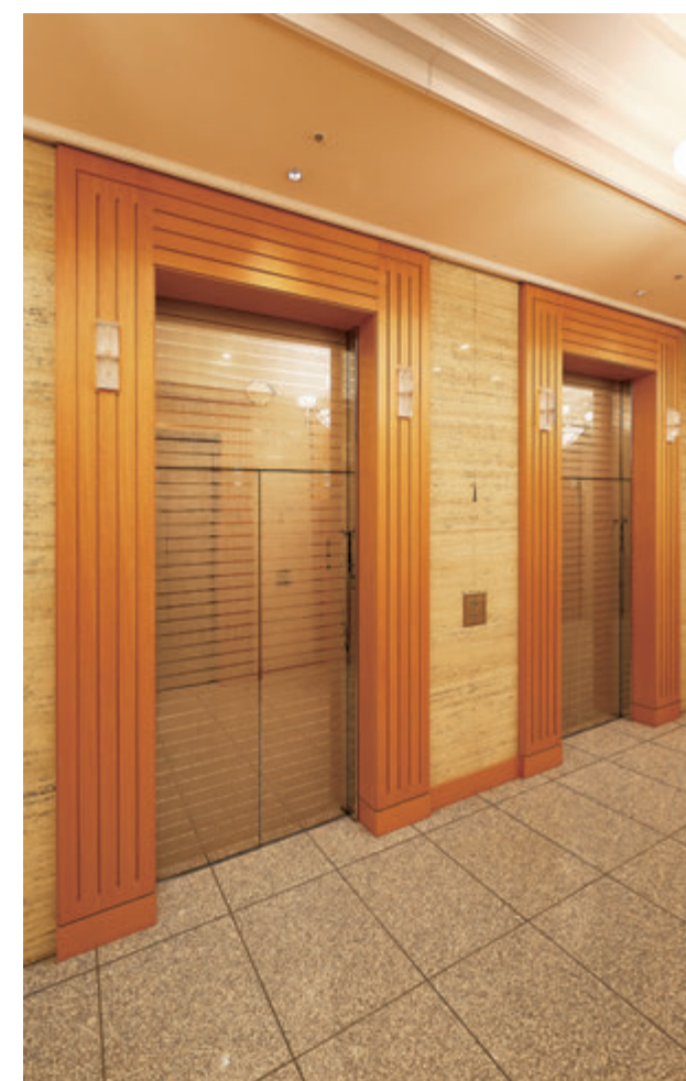
乗用24人乗りエレベーター・1階ホール (従来ののりば戸と三方枠を生かしたりリニューアル)
