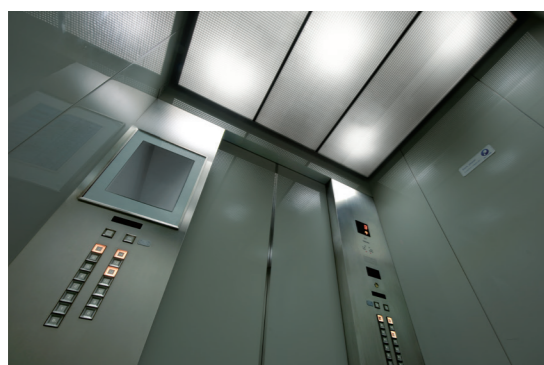
乗用24人乗りエレベーター・かご室天井(リニューアル前)
