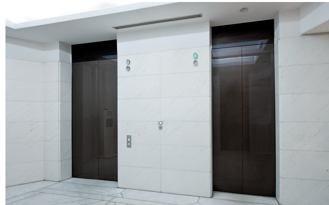
乗用24人乗りエレベーター・1階ホール
