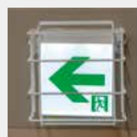
誘導灯にカバー設置
