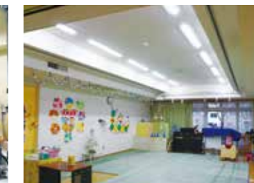
訓練室のLED照明
