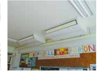
教室内天井吊形室内機
