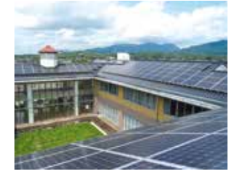
校舎屋根に設置された太陽光パネル
