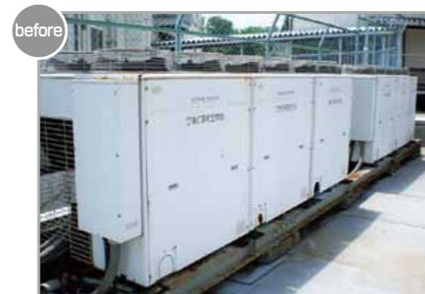
老朽化し、冷暖房効率の低下がコスト高を招いていた旧式の室外機
