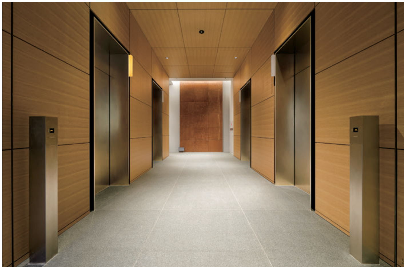
乗用15人乗りエレベーター / 左側奥：人荷用（兼非常用）17人乗りエレベーター・1階
