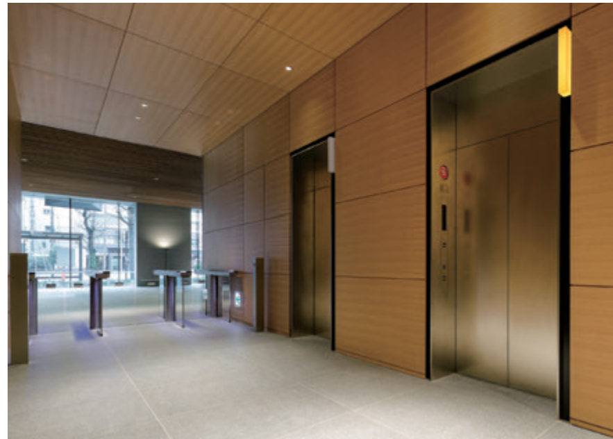
左側：乗用15人乗りエレベーター / 右側：人荷用（兼非常用）17人乗りエレベーター・1階
