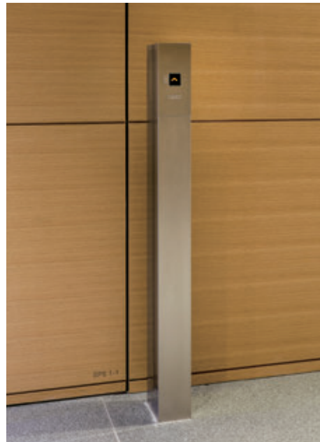
のりばボタン・1階（のりばボタン用ポールは建築工事）
