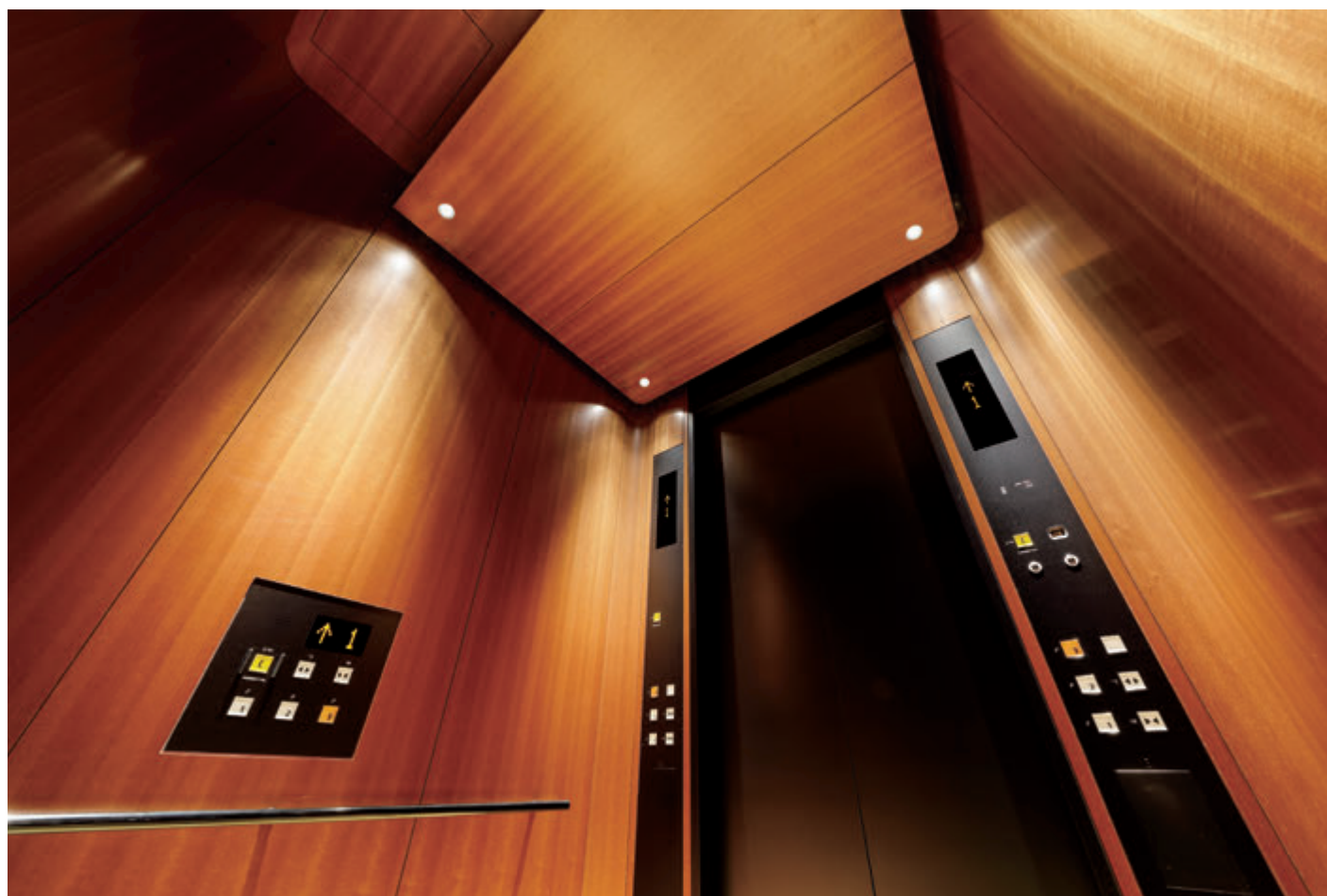
人荷用(兼非常用)26人乗りエレベーター・かご室天井(NOVARE Archives)
