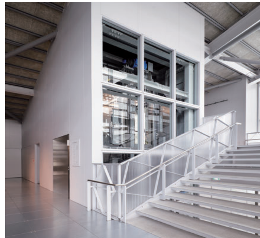
人荷用(展望用)18人乗りエレベーター・昇降路(NOVARE Academy)
