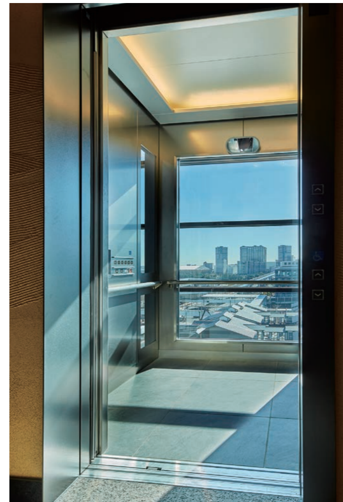
乗用(展望用)15人乗りエレベーター・かご室(東京豊洲 万葉倶楽部)
