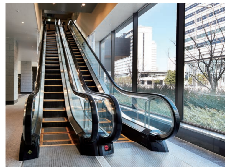
1階エスカレーター(豊洲場外 江戸前市場)
