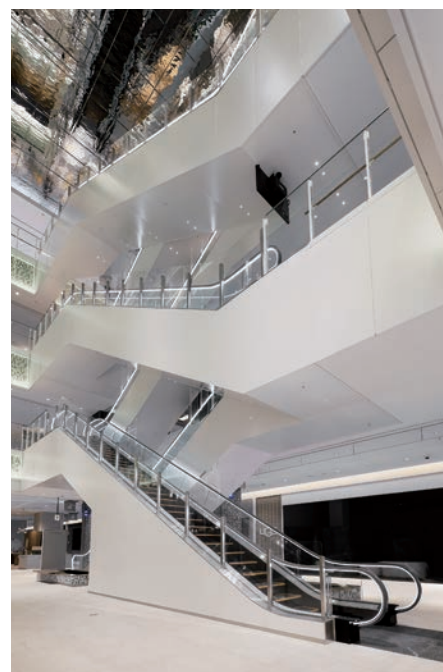
エスカレーター・全景
