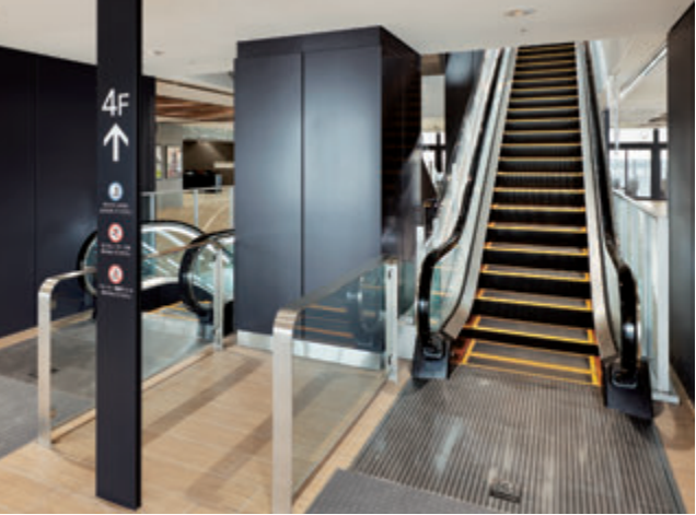
エスカレーター・3階
