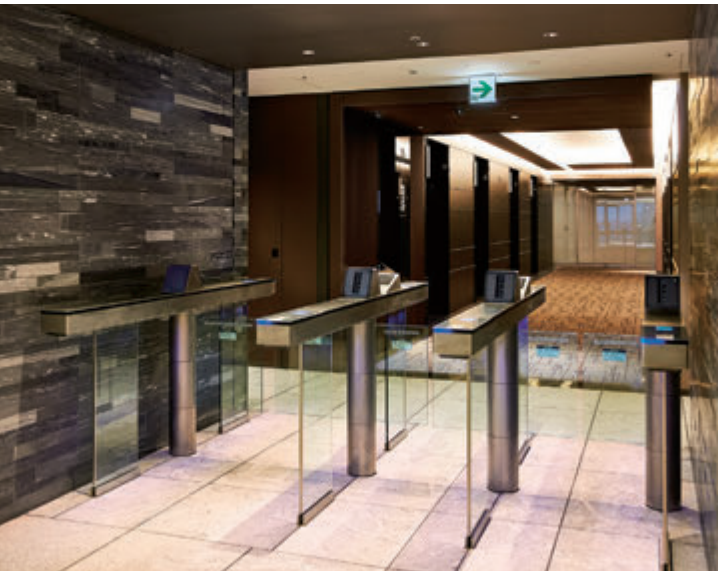
セキュリティゲート連動行先階予約システム・25階オフィスエントランス
