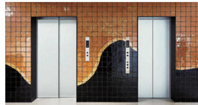
乗用20/13人乗りエレベーター・2階ホール（壁面：小砂焼陶板（栃木県指定伝統工芸品））
