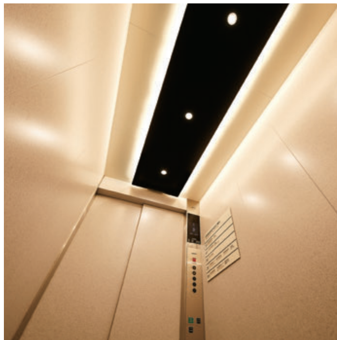
乗用20人乗りエレベーター・かご室天井
