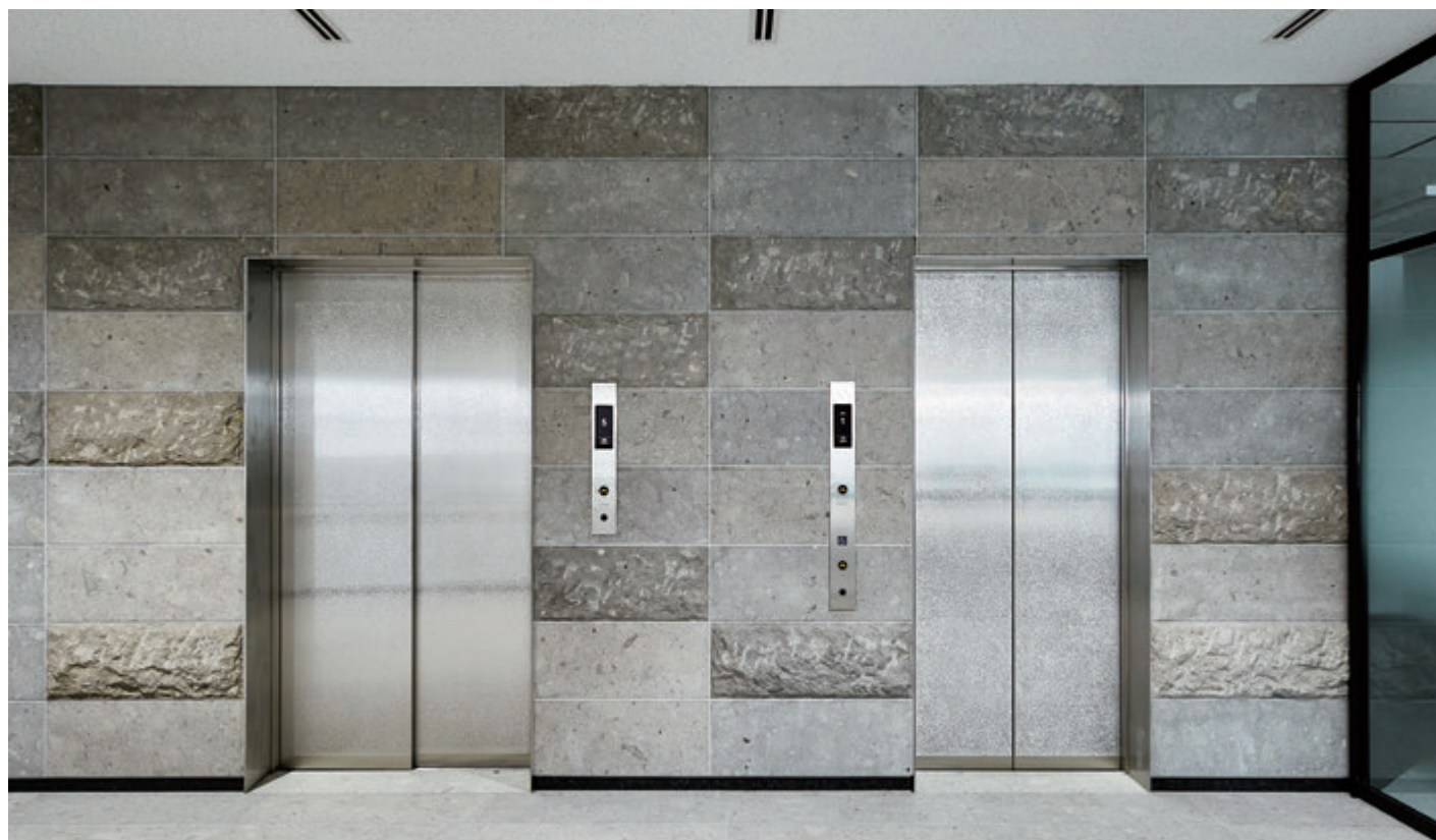
乗用20/13人乗りエレベーター・1階ホール（壁面：芦野石（県北産材））
