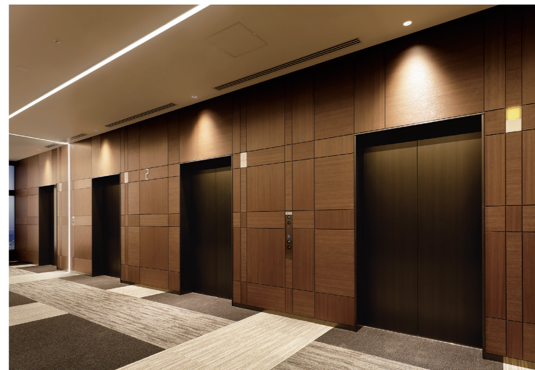
乗用24人乗りエレベーター・2階ホール
