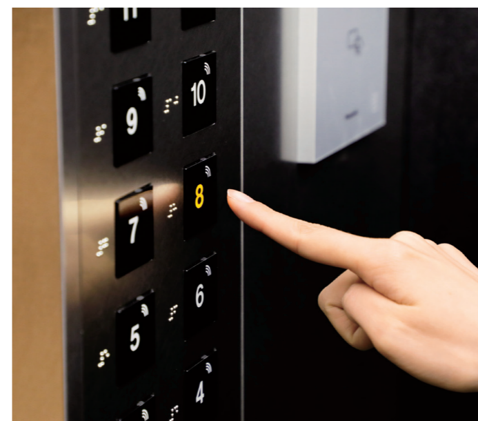
乗用24人乗りエレベーター・非接触ボタン(かご操作盤)
