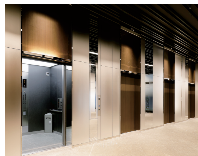
乗用24人乗りエレベーター・1階ホール
