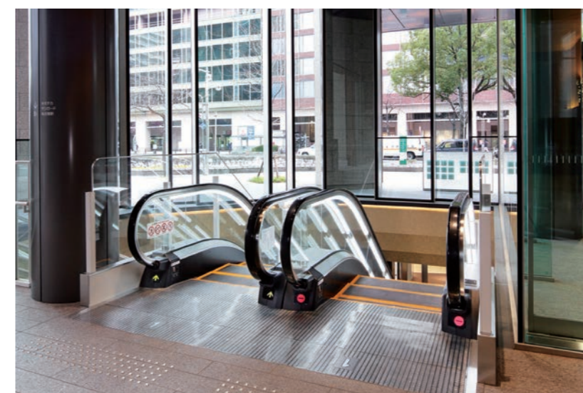
エスカレーター・1階
