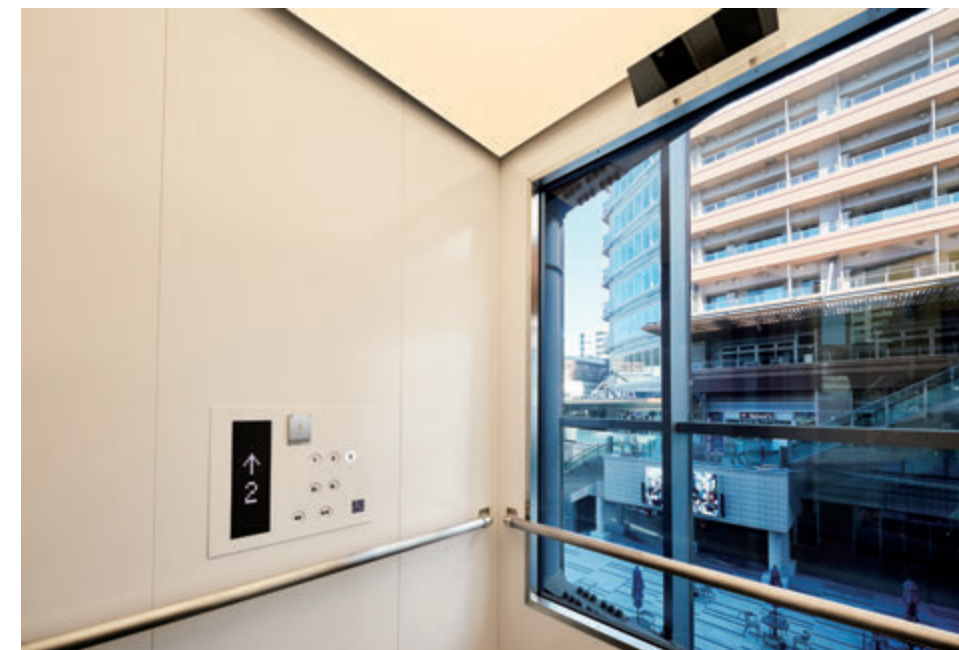
展望用15人乗りエレベーター・かご室(パークシティ武蔵小山 ザモール)
