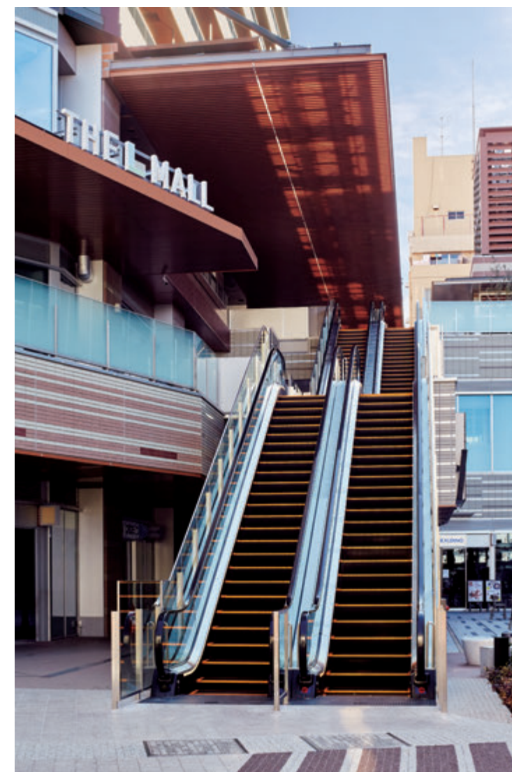
エスカレーター(パークシティ武蔵小山 ザモール)
