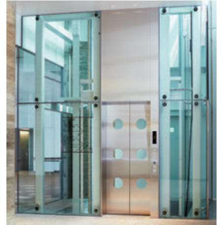
展望用18人乗りエレベーター・1階エレベーターホール
