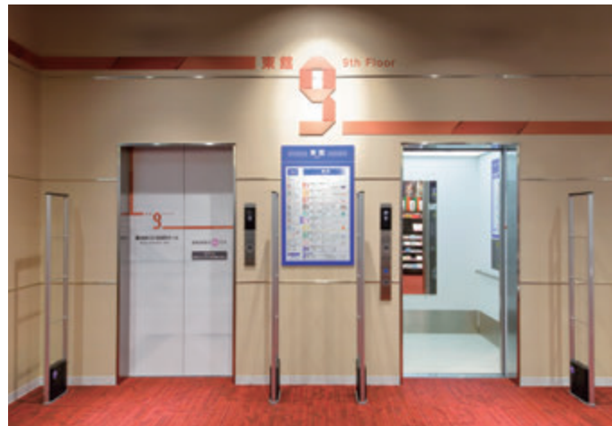
乗用15人乗りエレベーター・9階エレベーターホール
