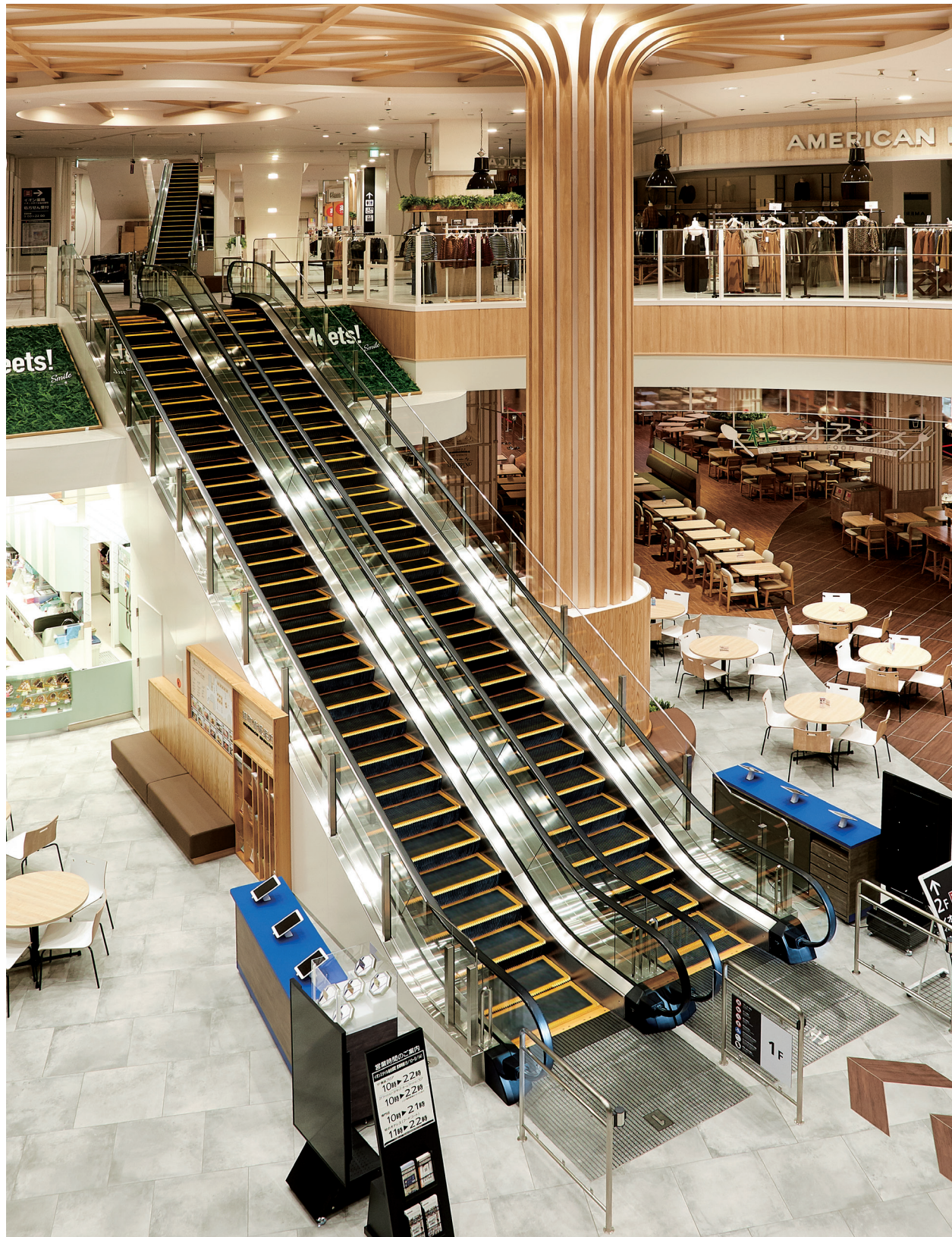
エスカレーター・1階
