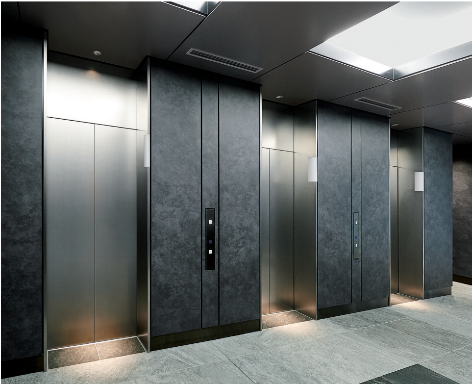
乗用15人乗りエレベーター・1階ホール
