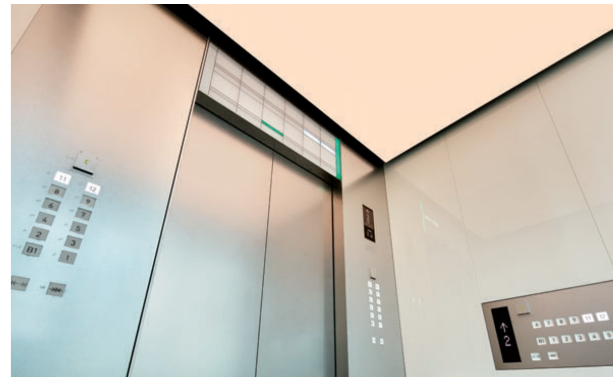
展望用24人乗りエレベーター・かご室天井
