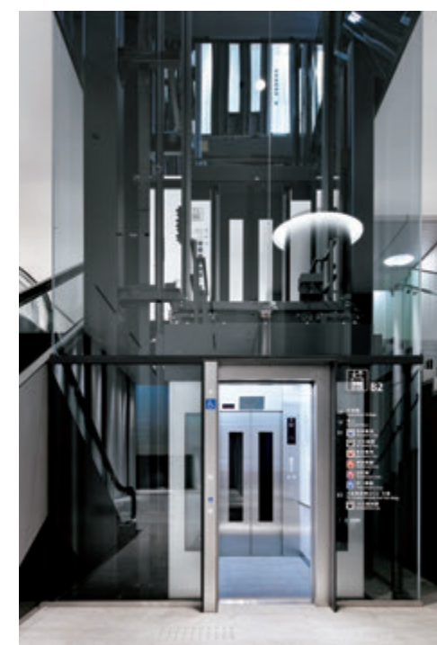
乗用20人乗りエレベーター・B2階エレベーターホール
