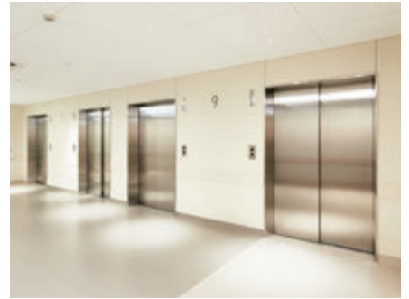
寝台用15人乗りエレベーター・1階ホール
