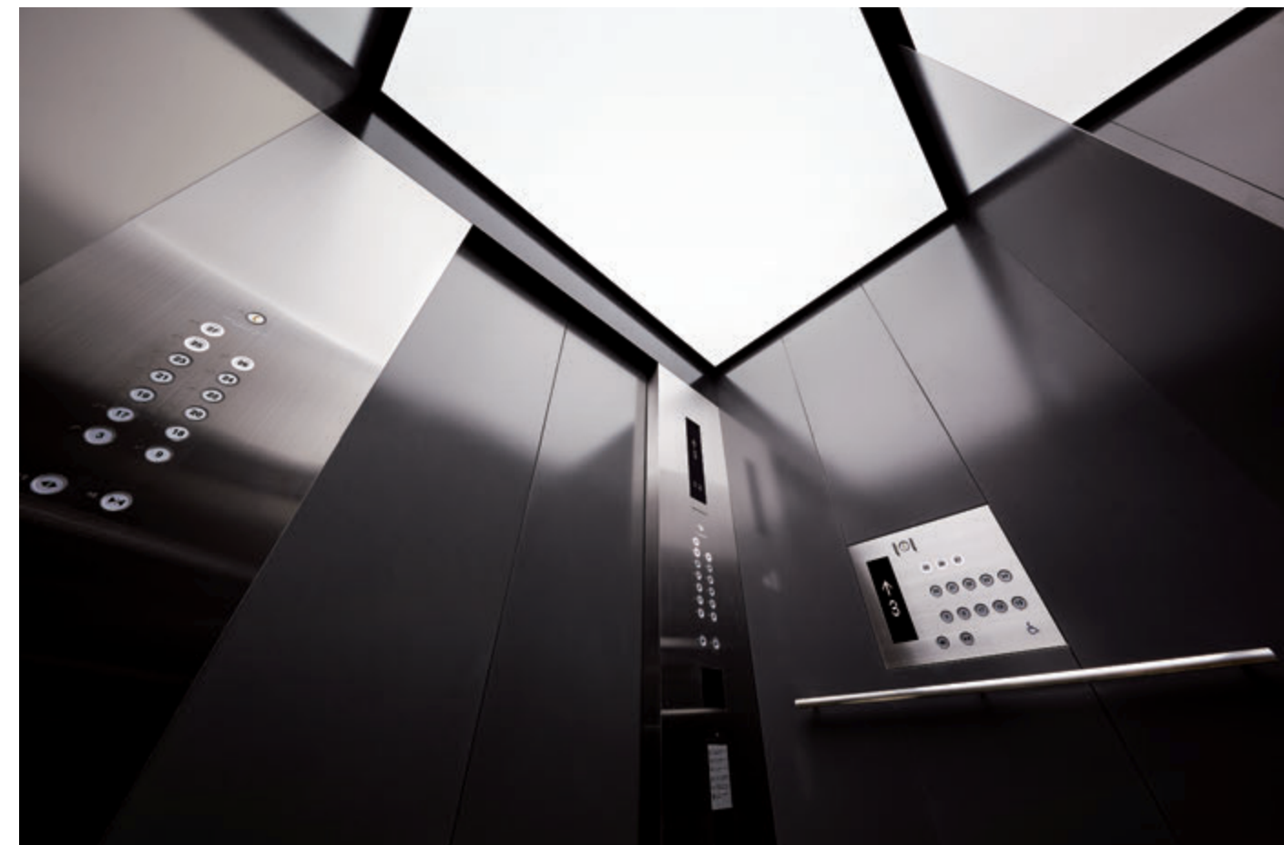
乗用24人乗りエレベーター・かご室天井
