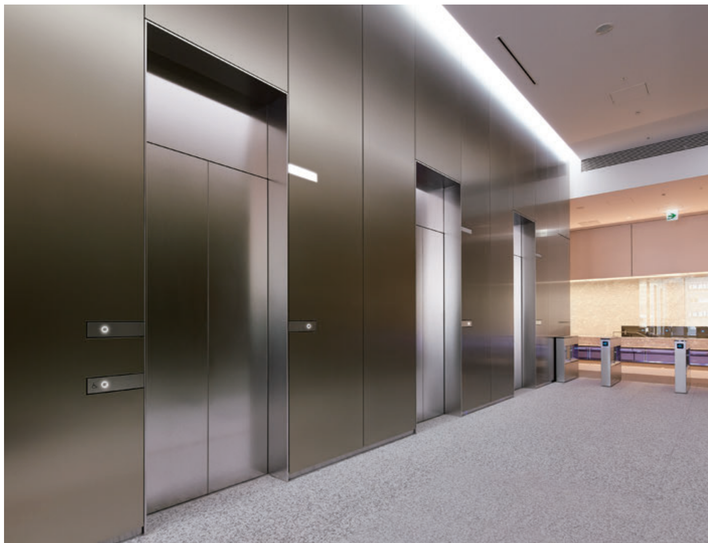
乗用24人乗りエレベーター・3階ホール
