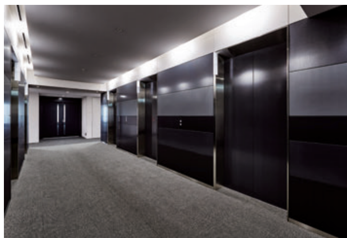
乗用24人乗りエレベーター・9階ホール
