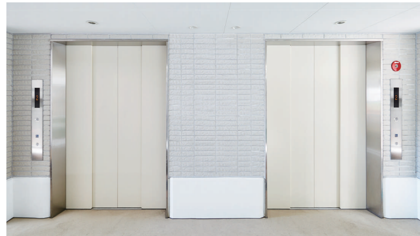
乗用24人乗りエレベーター／乗用(非常用)26人乗りマシンルームレスエレベーター・1階ホール
