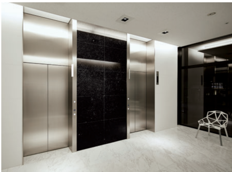
乗用17人乗り／15人乗りエレベーター・10階ホール
