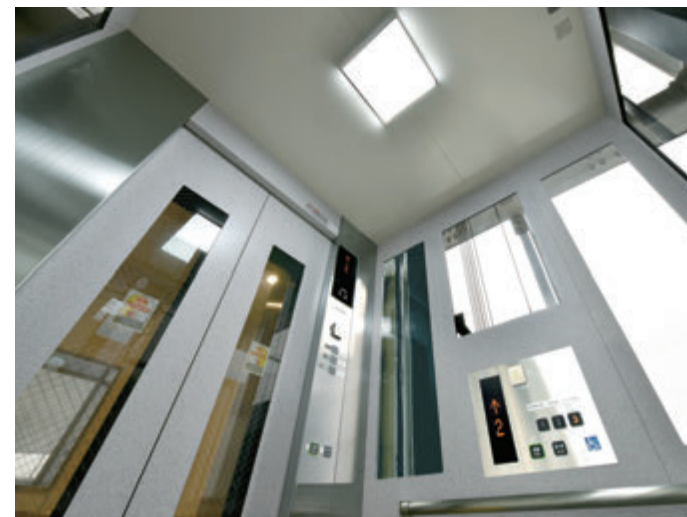
乗用15人乗りエレベーター・かご室天井 (千葉都市モノレール千葉駅連絡通路)
