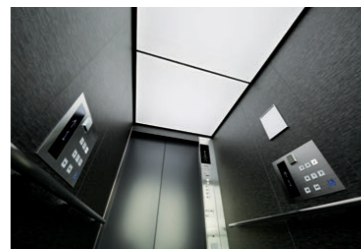
展望用26人乗りエレベーター・かご室天井
