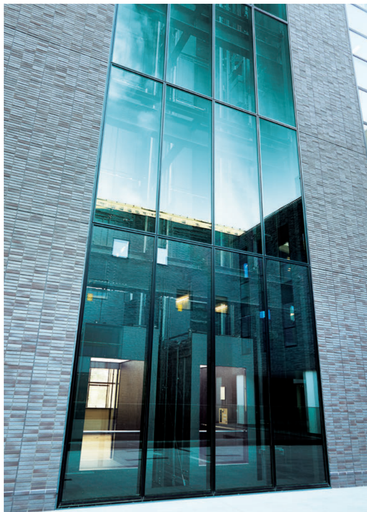
展望用26人乗りエレベーター・昇降路
