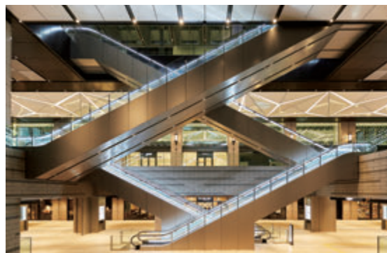
エスカレーター・ガレリア吹き抜け (B1階地下広場から3階オフィスロビー)
