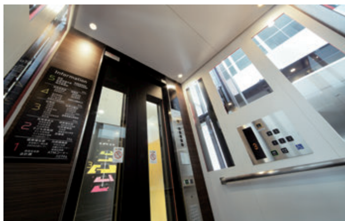
展望用エレベーター・かご室天井
