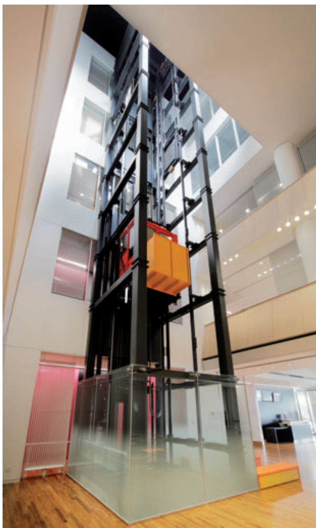
展望用エレベーター・昇降路外観
