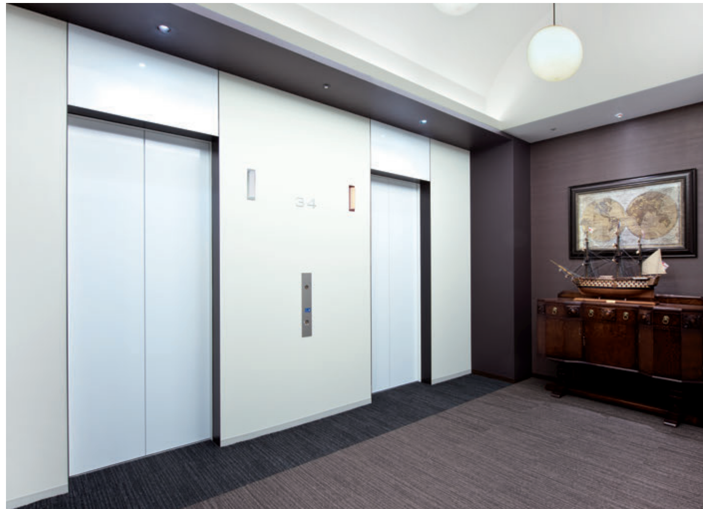
乗用11人乗りエレベーター・34階ホール
