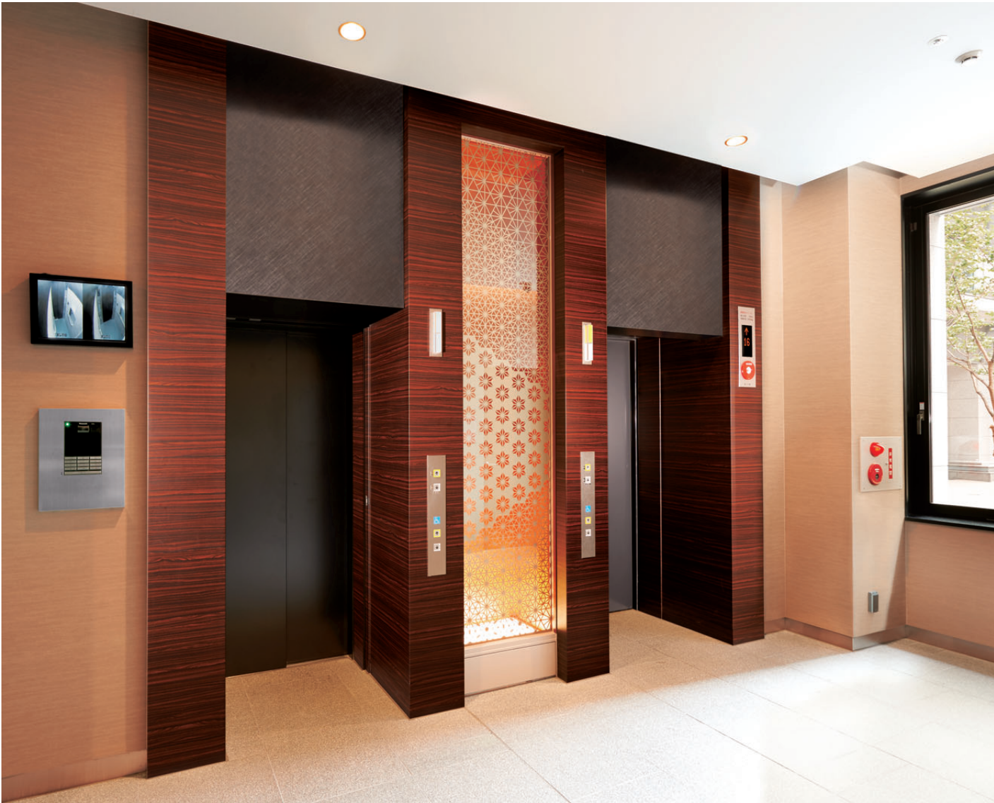
乗用9人乗りエレベーター／人荷用20人乗りエレベーター・ロビー階ホール(住宅)
