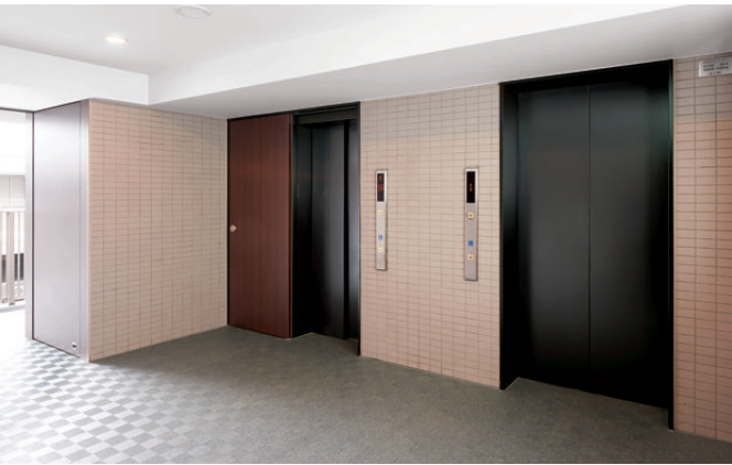
人荷用20人乗りエレベーター／乗用9人乗りエレベーター・16階ホール(住宅)
