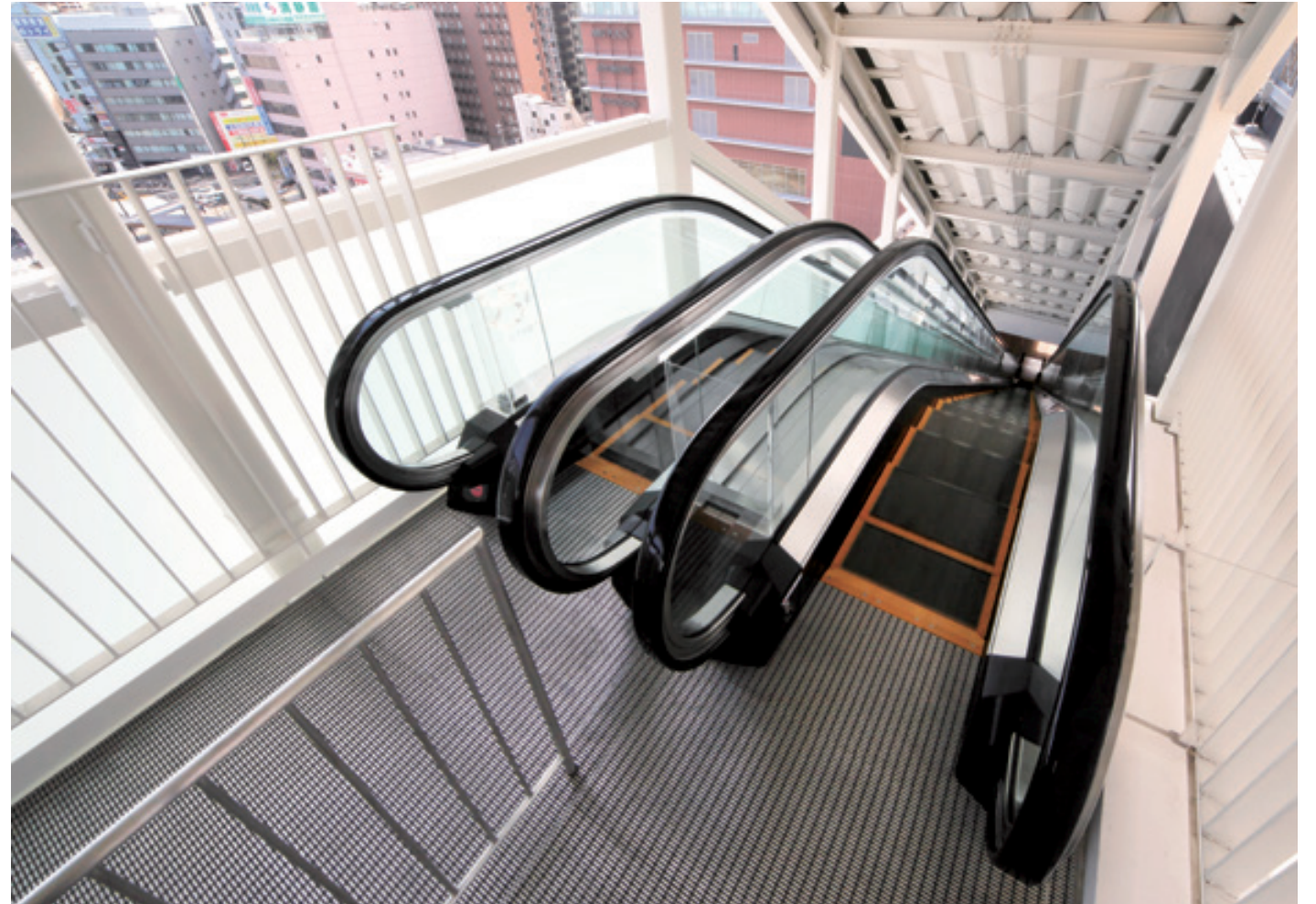
シティ屋上広場・エスカレーター
