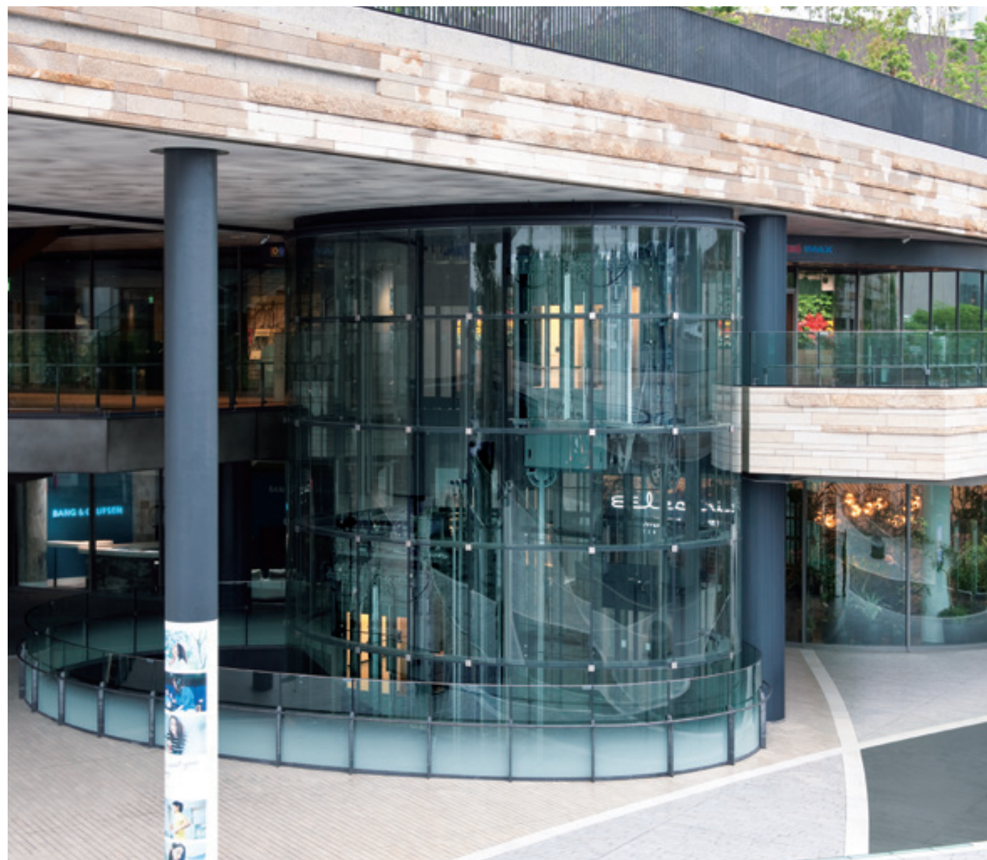
展望用エレベーター・昇降路
