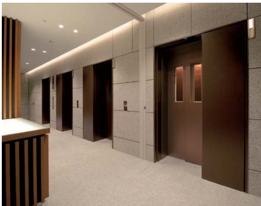
乗用13人乗りエレベーターと人荷用26人乗りエレベーター・1階ホール
