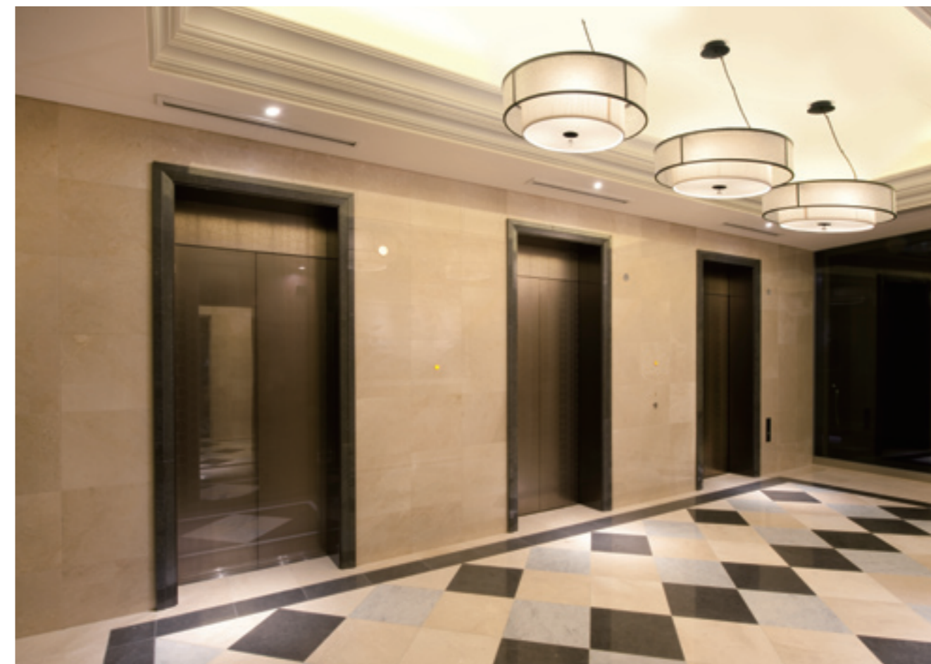
乗用13人乗りエレベーター・19階ホール
