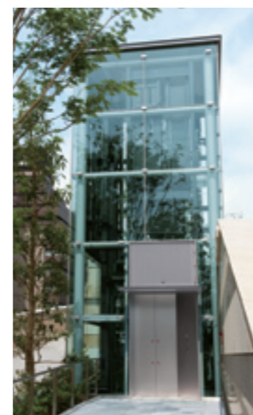
乗用22人乗りエレベーター・昇降路(大階段)
